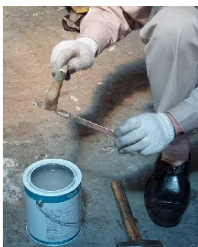
写真1 解体矢への滑剤の塗布
