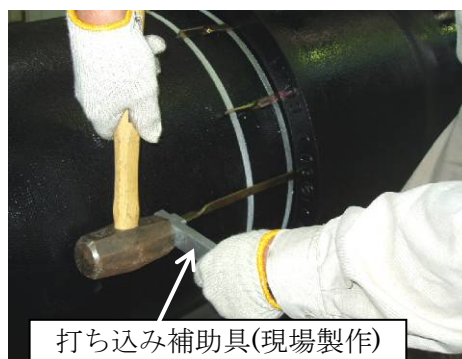
写真2 解体矢の打ち込み
