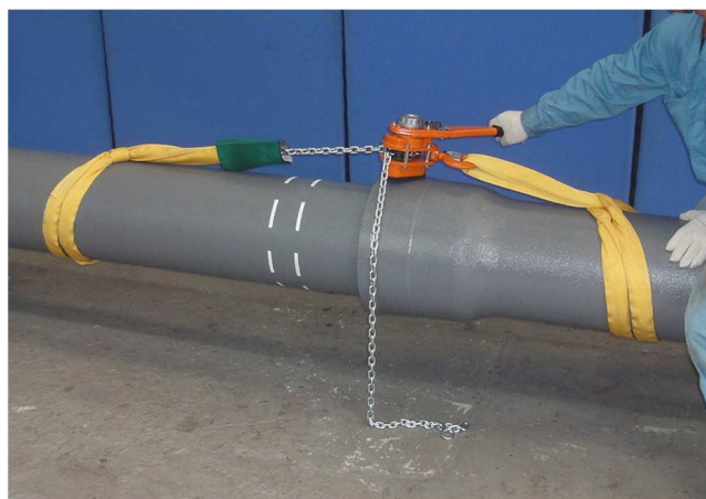
写真3 1点引きによる直管の接合
