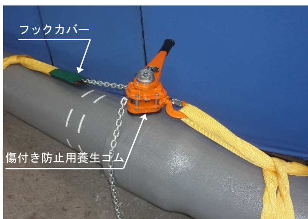
写真2 GX形チェーンレバーホイストのセット状態
