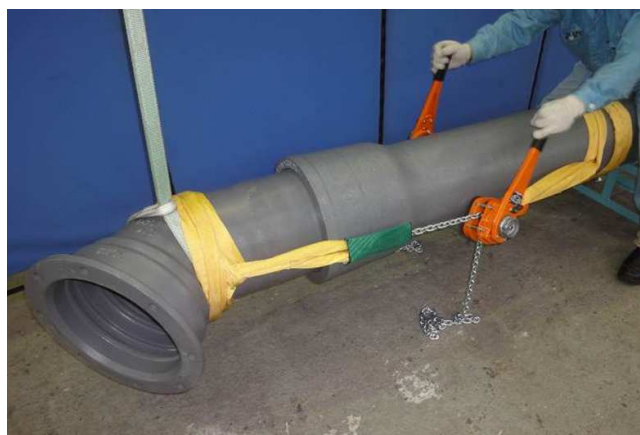
写真5 2点引きによる異形管の接合
