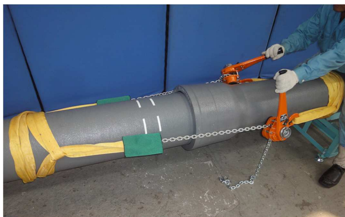
写真4 2点引きによる短管の接合
